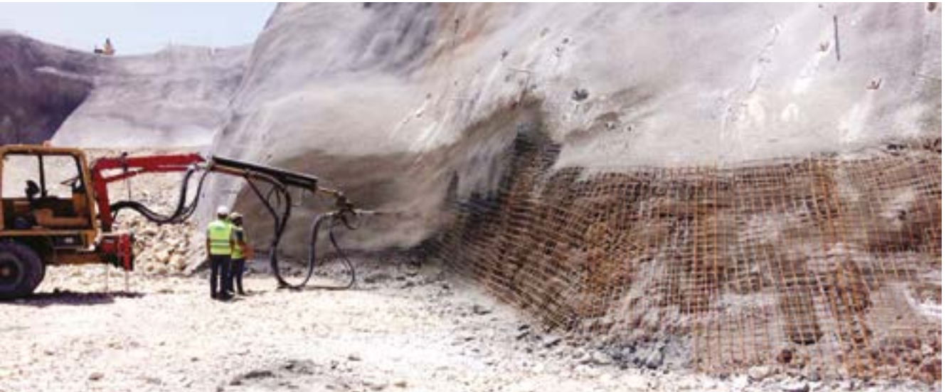
Şekil 6. Giriş yarma şevinde çift kat hasır çelik ve püskürtme beton uygulaması
