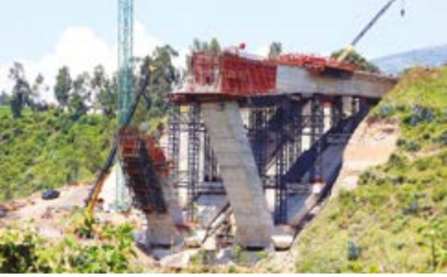
Şekil 4. Dünya'da şu ana kadar yapılmış olan tek eğik ayaklı konsol köprü – Chiche Köprüsü (Ekvador)
