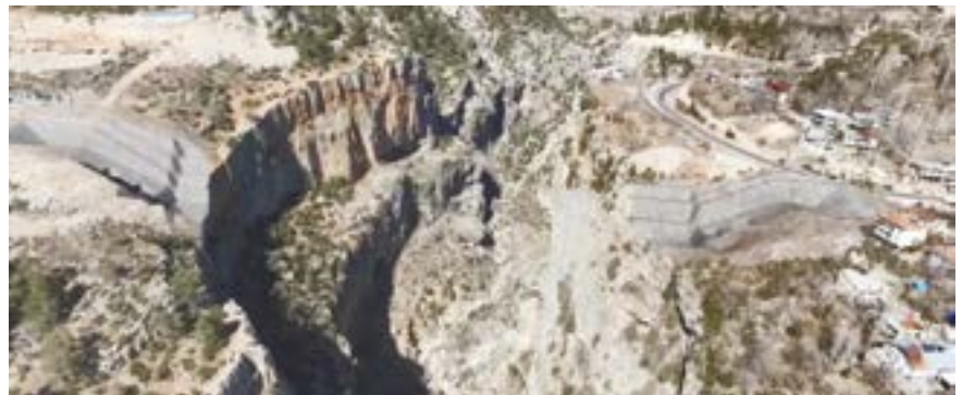
Şekil 5. Çamlıca köprüsü giriş ve çıkış kazı şevleri (Animasyon)
