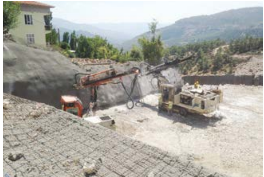
Şekil 8. Çıkış yarma şevinde delme ve bulon yerleştirme uygulaması
