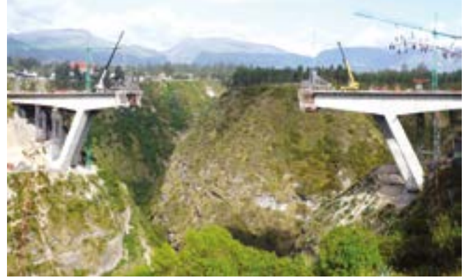
Şekil 4. Dünya'da şu ana kadar yapılmış olan tek eğik ayaklı konsol köprü – Chiche Köprüsü (Ekvador)
