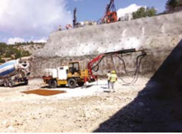
Şekil 9. Çıkış yarma şevinde hasır çelik ve püskürtme beton uygulaması
